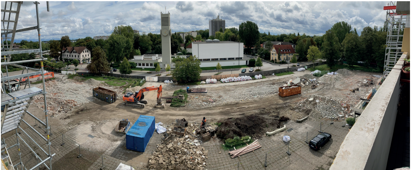
Baustelle Alois-Harbeck-Platz Foto: Stegen 07/2022
